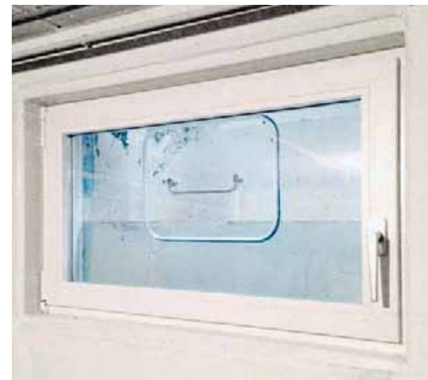
Nachträglicher Einbau von Vorsatzscheiben
