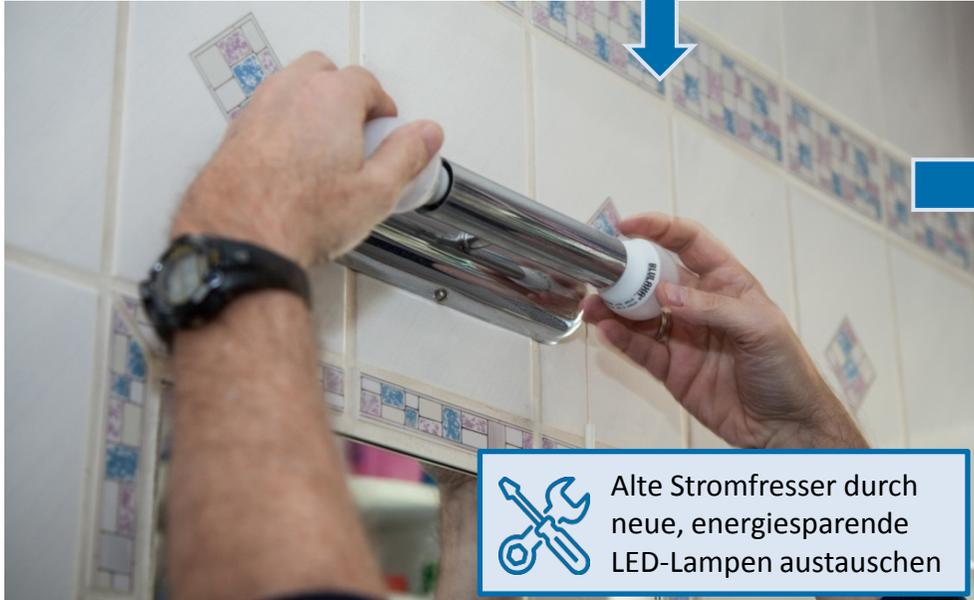
Alte Stromfresser durch neue, energiesparende LED-Lampen austauschen
